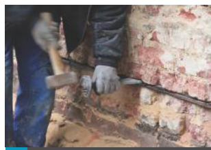
4 Wbijanie klina na płycie izolacyjnej
