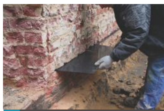
3 Wkładanie w szczelinę płyty z polietylenu HD
