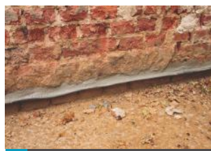
6 Szczelina wypełniona pęczniejącą zaprawą wtłoczoną pod ciśnieniem 5 barów
