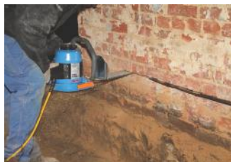
1 Podcinanie muru za pomocą piły łańcuchowej PES1300
