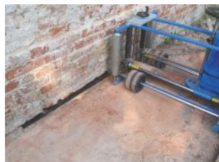
2 Podcinanie muru od wewnątrz przy użyciu samojezdnej piły PMS25
